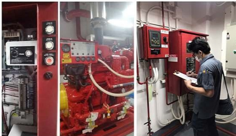
ภาพที่ 4-8 ห้องเครื่องประปา และเครื่องสูบน้ำอัตโนมัติ และตรวจสอบดูแลรักษาระบบ
