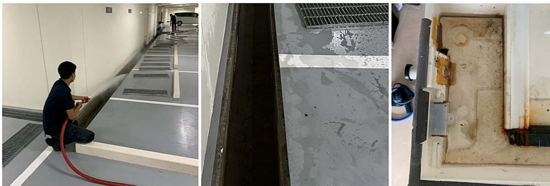
ภาพที่ 4-26 แนวท่อระบายน้ำ และรางระบายน้ำ ทำความสะอาดบ่อพักน้ำและรางระบายน้ำ
